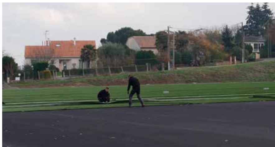
Pose des lés de gazon synthétique sur la couche de souplesse..
